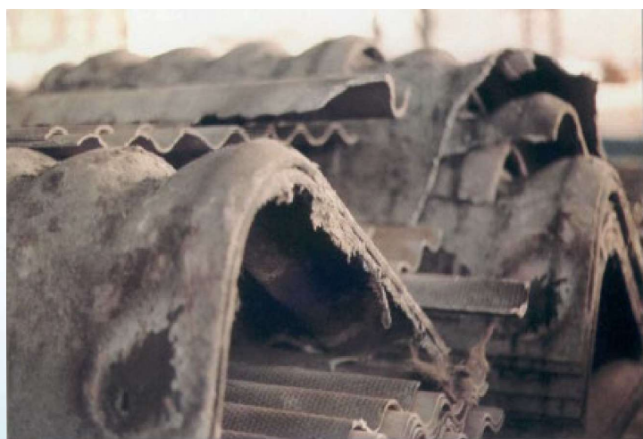
19. Lastre ondulate di copertura in cemento-amianto; si nota la situazione di degrado con fibre che sporgono dalla superficie dei manufatti, a causa del progressivo disgregarsi della matrice cementizia
